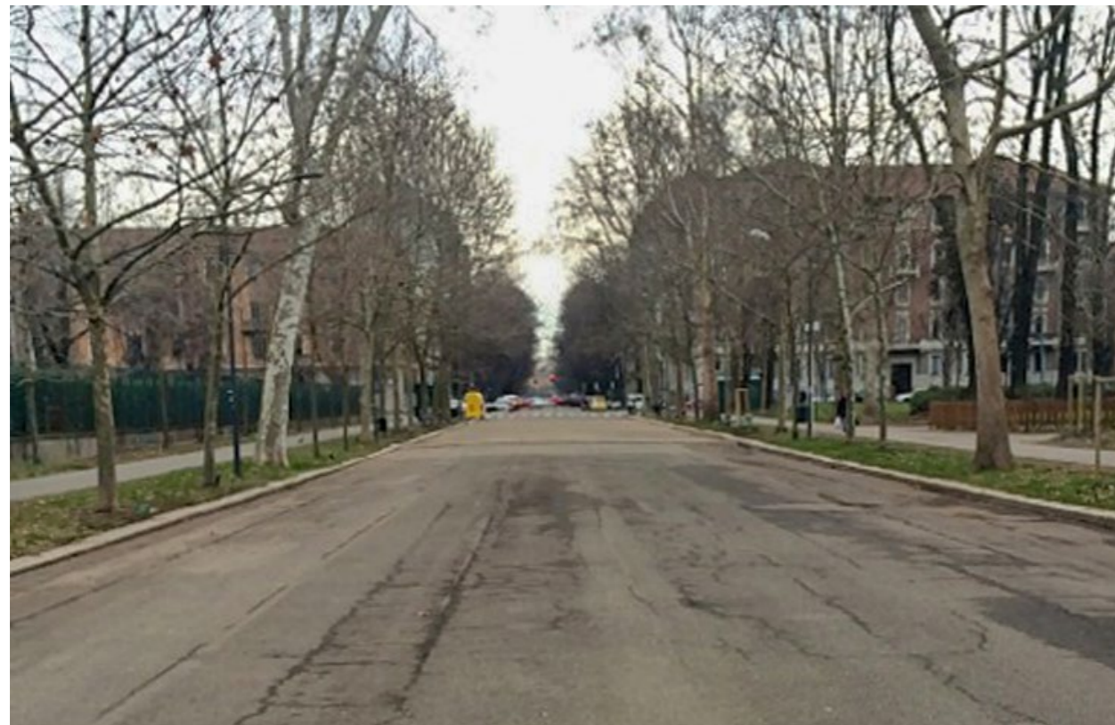
foto: via Bach prima dell'intervento di depavimentazione, Milano © Comune di Milano
