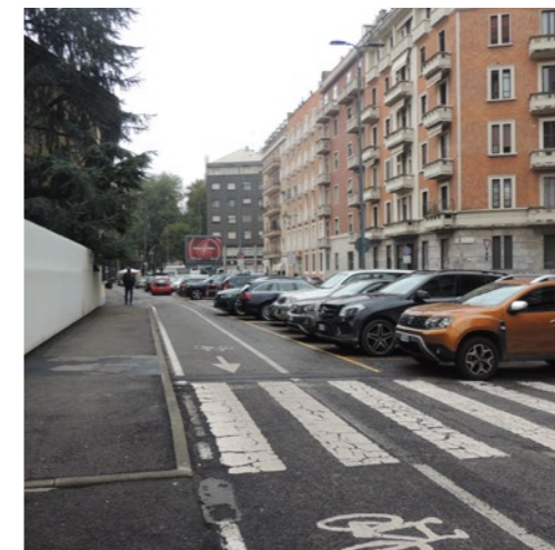
monodirezionale in segnaletica, protetta da sosta, in direzione opposta al senso di marcia
