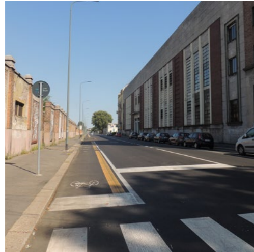
linea avanzata (pista ciclabile in corsia riservata tracciata in carreggiata) intersezione semaforizzata
