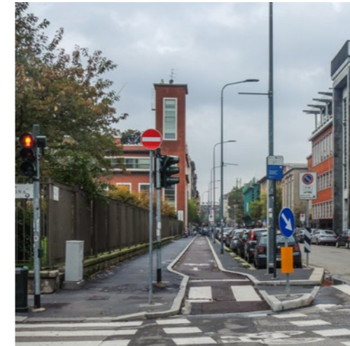
monodirezionale in sede propria, protetta da sosta, in direzione opposta al senso di marcia
