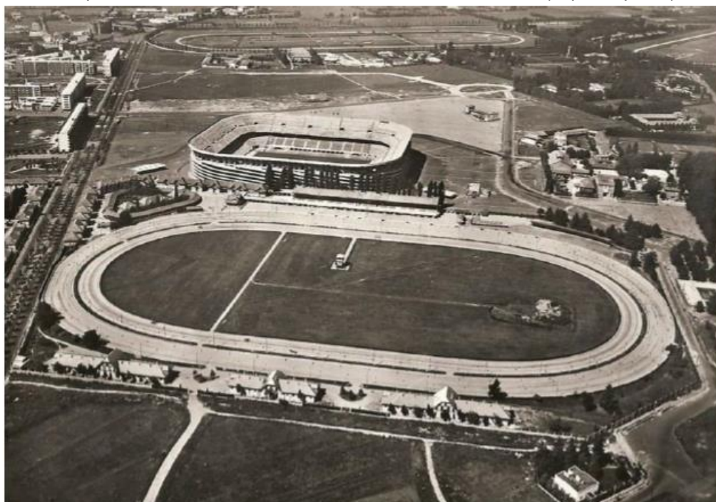
Figura 4-45 – Lo stato dell'area sportiva dopo la costruzione del secondo anello dello stadio e il completamento delle scuderie/fienili sul lato est del Trotter (in primo piano)
