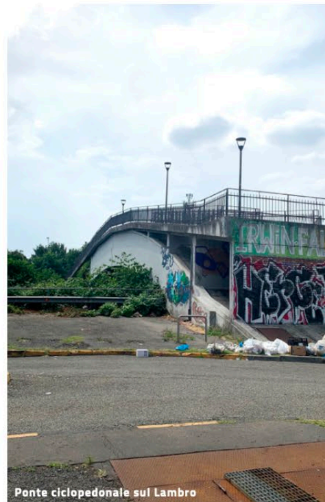
Ponte ciclopedonale sul Lambro
