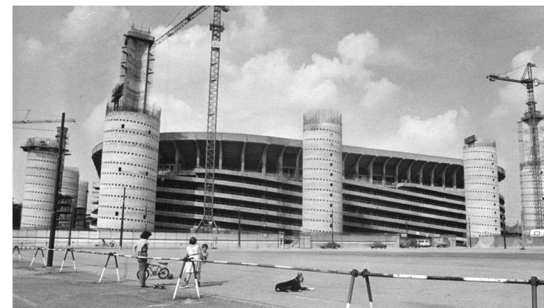
Fig. 18: La costruzione delle torri
