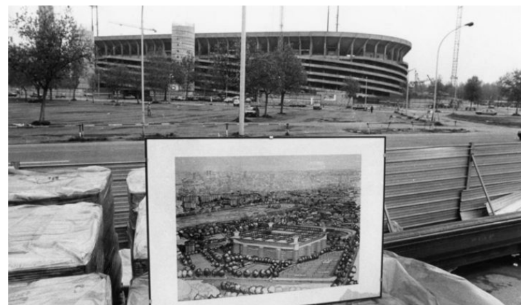
Fig. 17: L'inizio del cantiere
