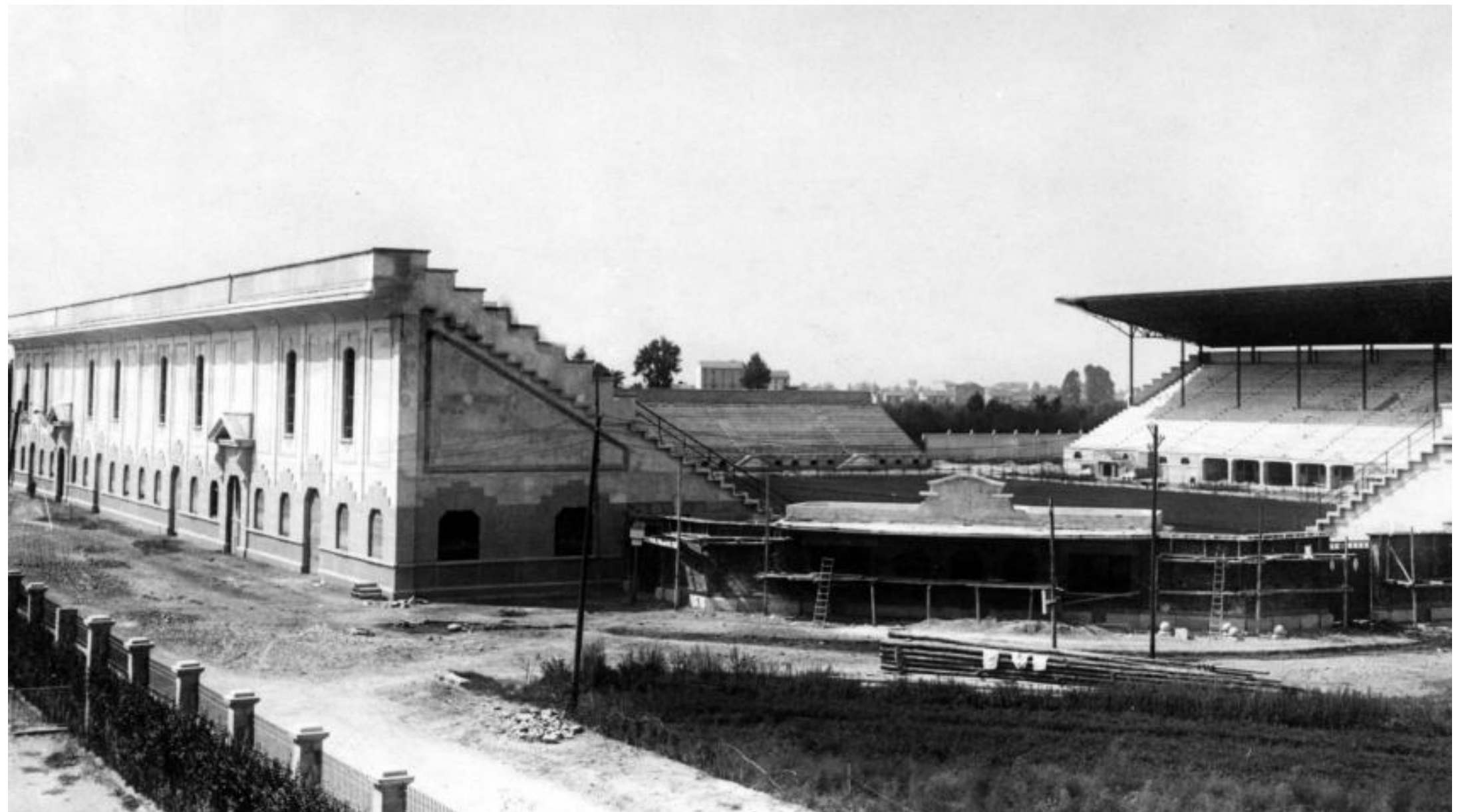
Fig. 05: Vista da via Piccolomini
