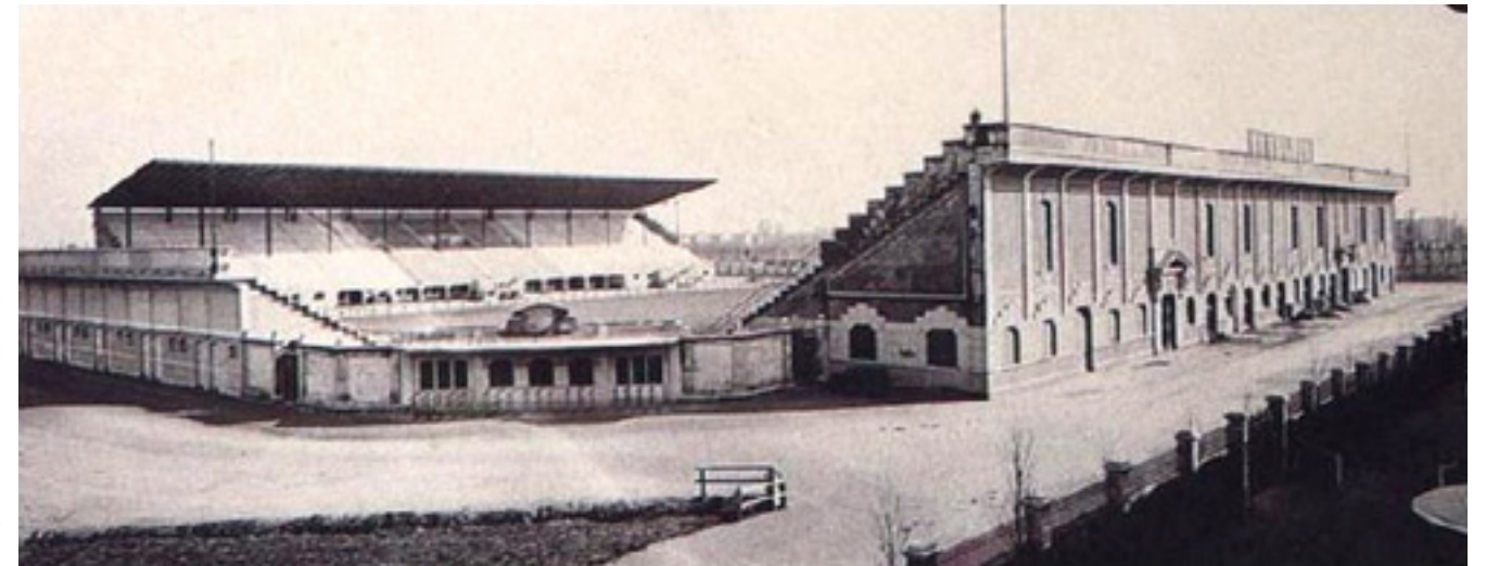
Fig. 03: Vista da via Dessiè
